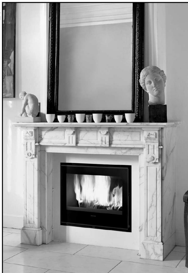
Pose en foyer
