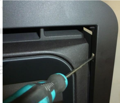
Figura n°12 - Manera de doblar las pestañas
